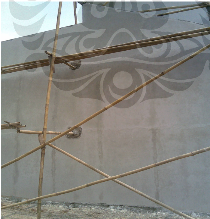
Gambar : Pelaksanaan plesteran + acian dengan Semen Mortar ” Karya Mortar ”
