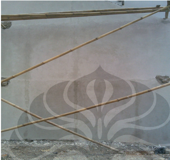
Gambar : Pelaksanaan plesteran + acian dengan Semen Mortar ” Karya Mortar ”
