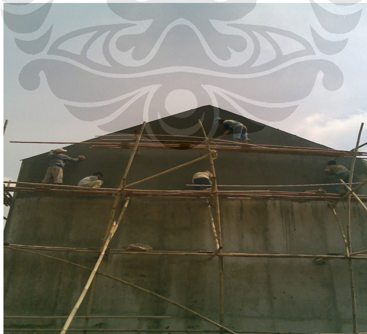
Gambar : Pelaksanaan plesteran + acian dengan Semen Mortar ” Karya Mortar ”
